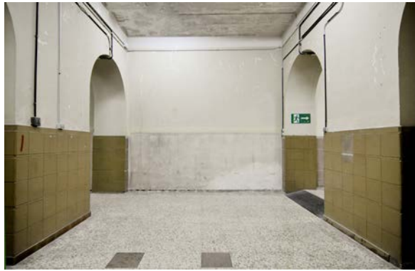
Tabacalera (Estudios). Vista parcial de las salas 2 y 3
